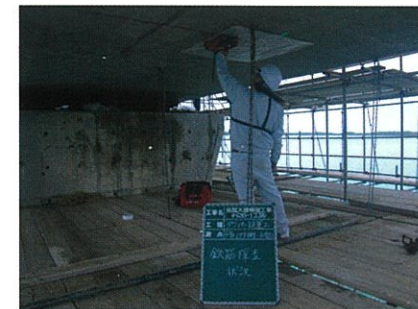
①鉄筋探査工
