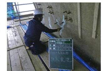
ひび割れ注入工
