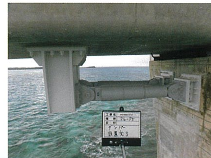
④ダンパー取付完了
