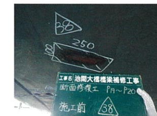
断面修復工(施工前)
