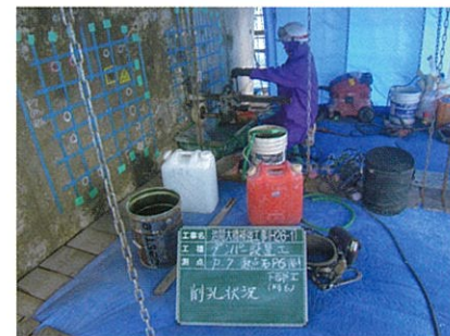
②アンカー筋削孔工
