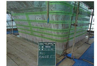
溝切陽極設置工
