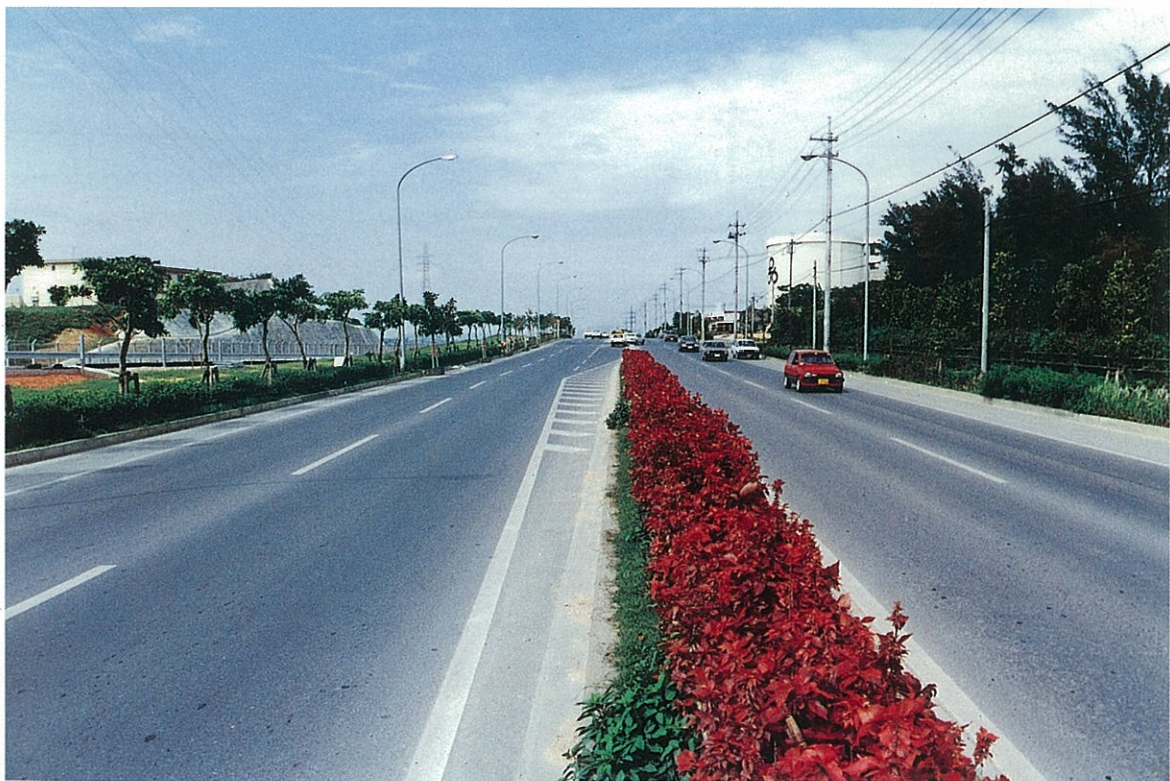
嘉手納米軍基地沿いの2車線を4車線に拡幅した。
