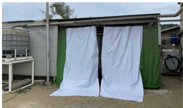
図11 シートによる遮蔽状況
