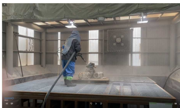
改善後の作業状況
