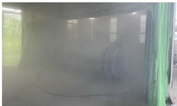
改善前の作業状況
