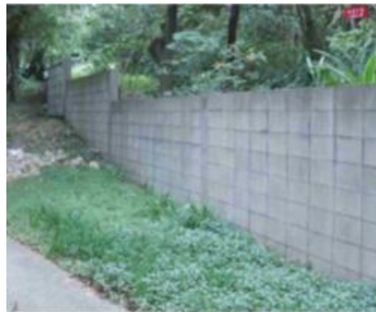
防蛇壁（ブロック塀）
