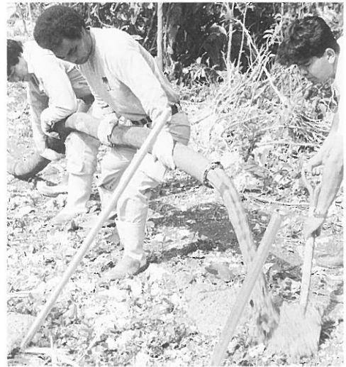
生コンの流し込み
