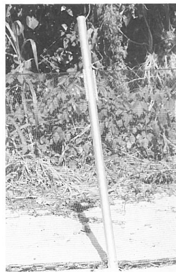
完成したフェンス
