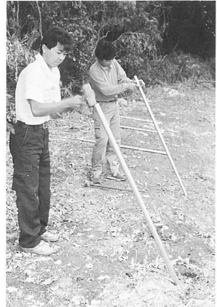
支柱の打ち込み
