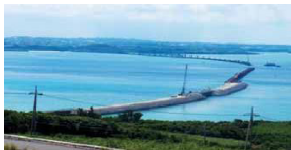
伊良部島側進捗状況写真 (平成22,6)
