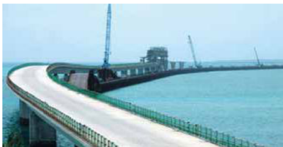
宮古島側進捗状況写真 (平成22,6)
