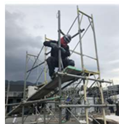
足場仮設工事
