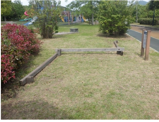
事故発生状況
