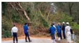
国道505号(名護市)の土砂崩れ現場
