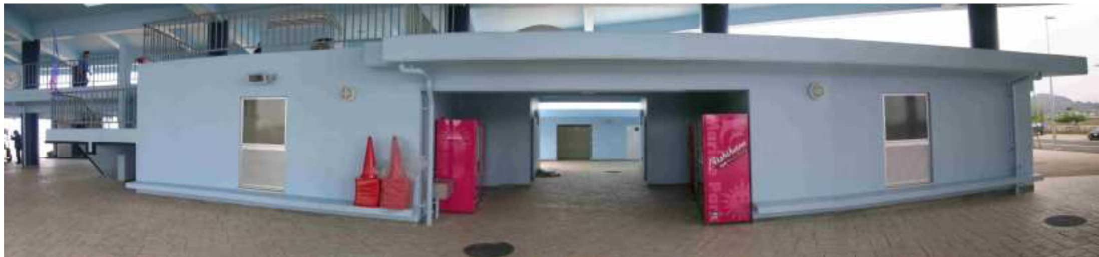
1階中央広場全景③
