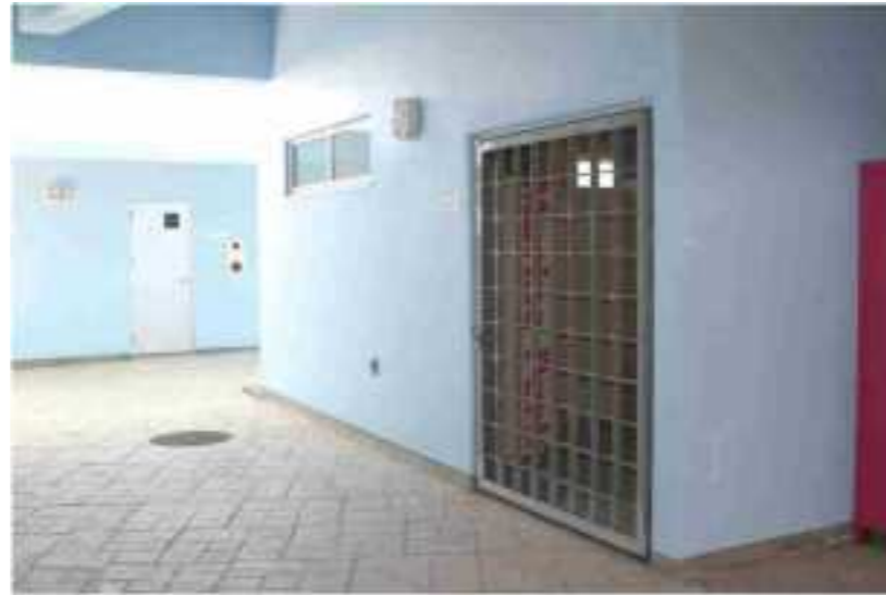
女子ロッカー・シャワー室
