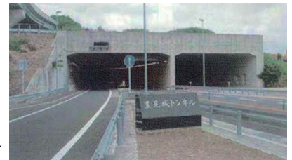
豊見城トンネル
