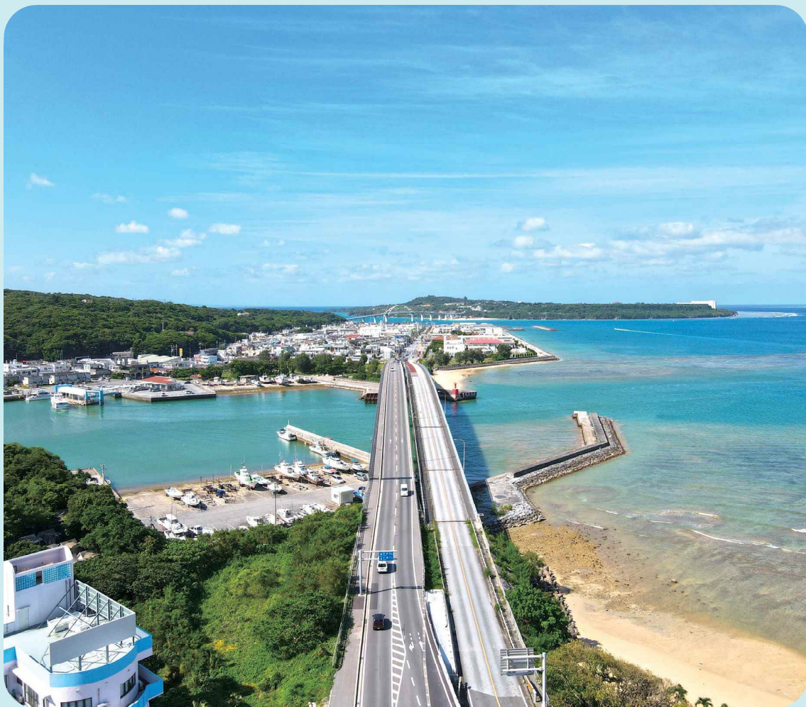
一般国道449号(県管理区間)本部大橋
