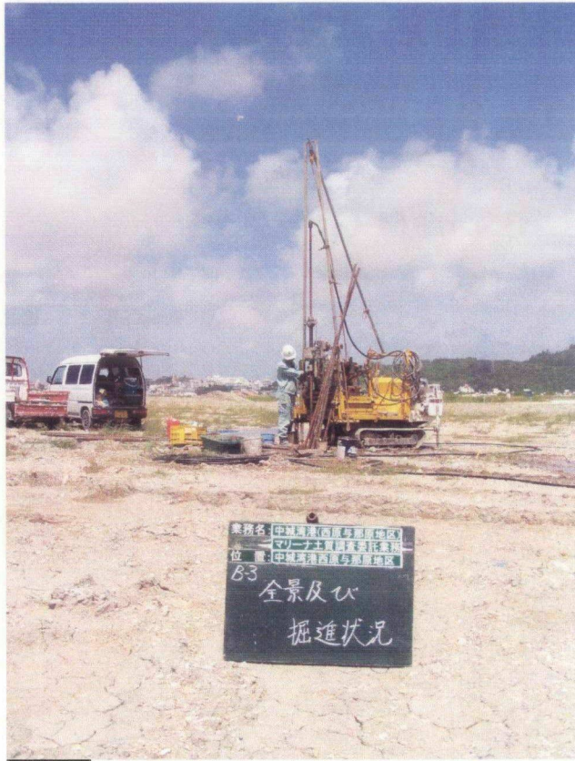
B-3 全景及び掘進状況
