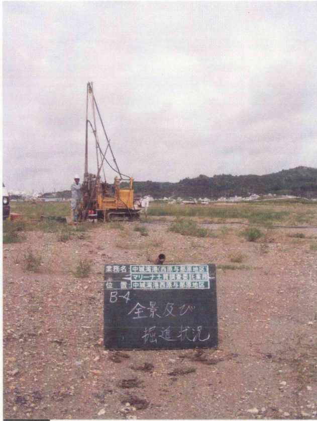
B-4 全景及び掘進状況
