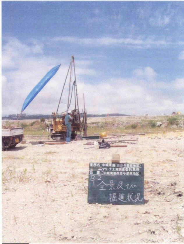
B-2 全景及び掘進状況
