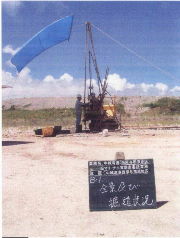
B-1 全景及び掘進状況
