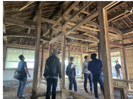
解体中の古民家
