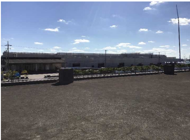
糸満漁港荷さばき施設③ 建設現場
