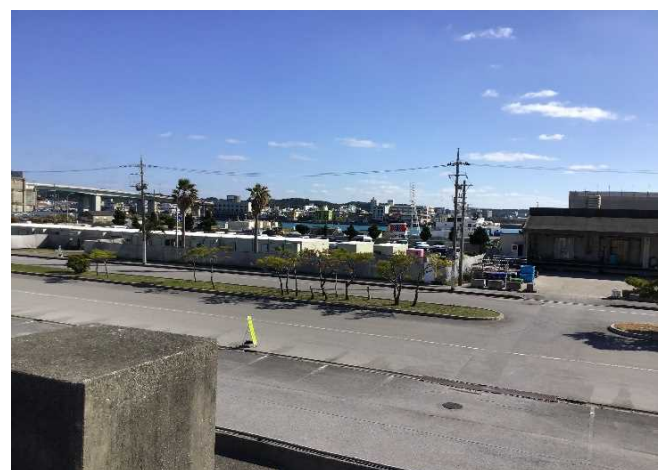
糸満漁港荷さばき施設建設現場⑥ 糸満漁港
