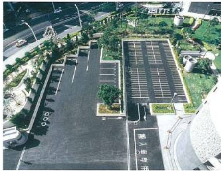
県庁行政棟より駐車場を望む
