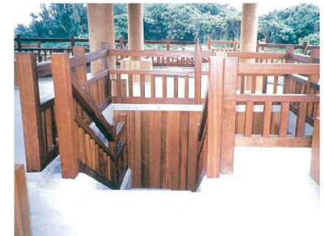
階段、展望フロアの木造手すり
