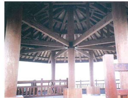
3階木造小屋部分
