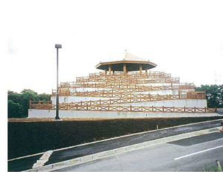
スロープ側正面より
