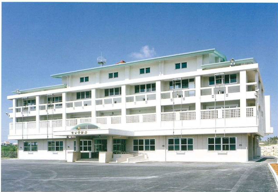
庁舎棟正面側
