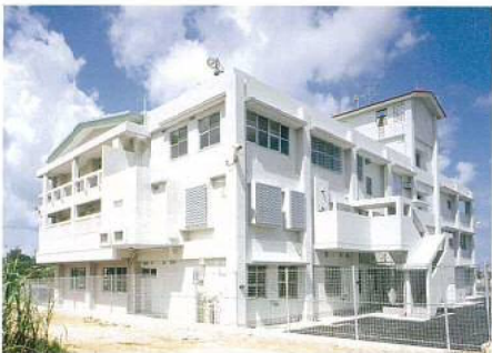
庁舎棟正南側
