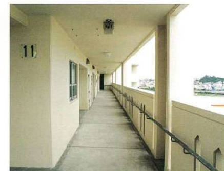
外廊下の手すり
