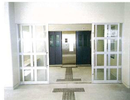
1階エレベーターホール入口
