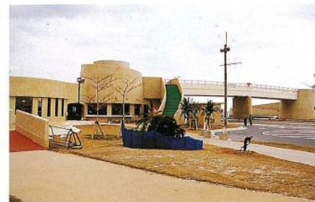
名称：伊計平良川線ロードパーク 道路情報室新築工事
