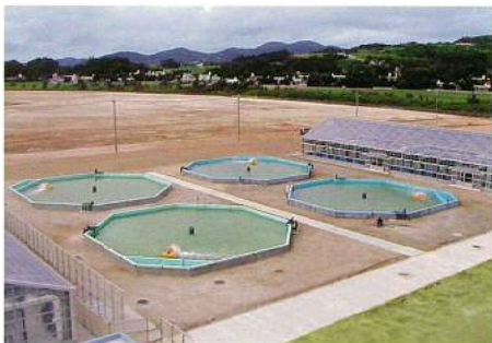
屋外水槽 FC造 250t水槽×4基 クルマエビは夏の高温に弱いことから、深層水の低温性を利用して水温を23℃以下に維持し、母エビの養殖を行う。
