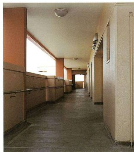
共有廊下部分 全ての共有部分に手すりを取り付け、 高齢者にも配慮した
