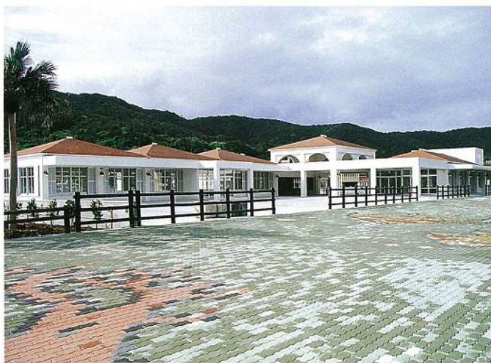
名称： 座間味港岸壁及び 物揚場附属施設工事 所在地：座間味村 工期：H11. 11. 25 ～H12. 3. 27 構造階数：RC造 1F 延床面積：1,218.45 m 2 総工事費：264,850 千円
