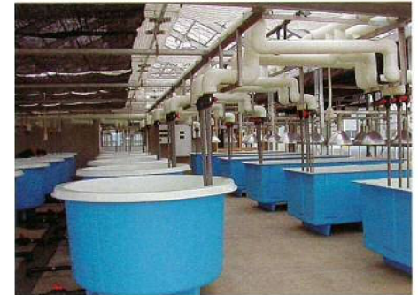
海藻・介類研究棟 S造 1F 延床面積 548.85m 2
