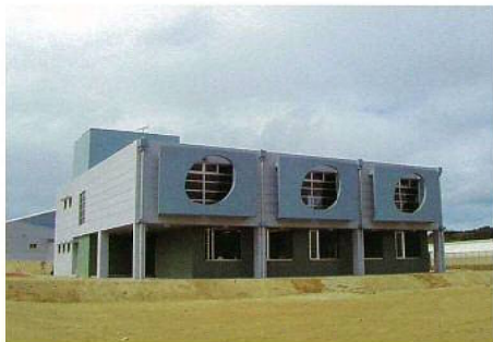
研究所本館 RC造 2F 延床面積 548.65m 2
