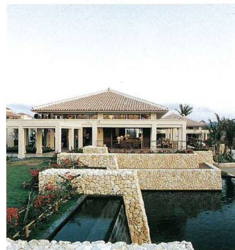
北側外観と修景池
