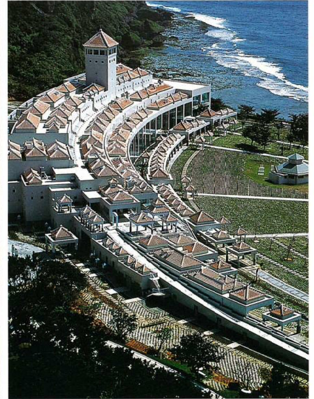
平和の火を中心とした同心円状の建物で、長さ220m、125の赤瓦屋根を持つ
