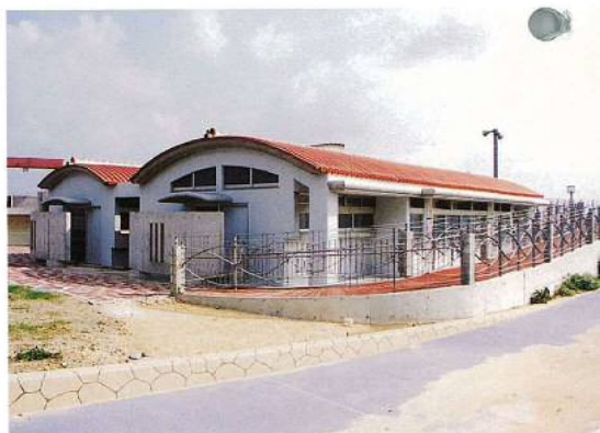
名称：中城港湾（安座真地区） 遊歩道付帯施設 （男子更衣室棟）新築工事 所在地：知念村 工期：H10.3.28～H10.9.30 構造：RC造（地上1階建） 延面積：170.797㎡ 総工事費：65,617千円
