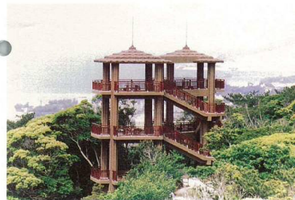
名称：名護中央公園展望台 新築工事 所在地：名護市 工期：H10.10.22～H11.3.20 構造：RC造（地上3階建） 延面積：237.96㎡ 総工事費：74,392千円
