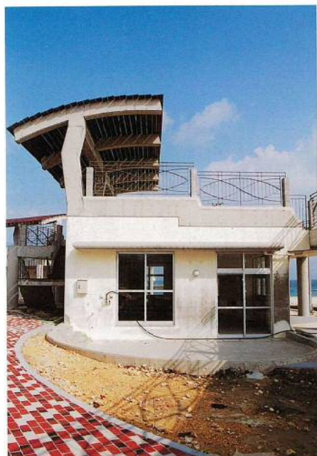
名称：中城港湾（安座真地区） 遊歩道付帯施設 （男子更衣室棟）新築工事 所在地：知念村 工期：H10.3.28～H10.9.30 構造：RC造（地上1階建） 延面積：170.797㎡ 総工事費：65,617千円
