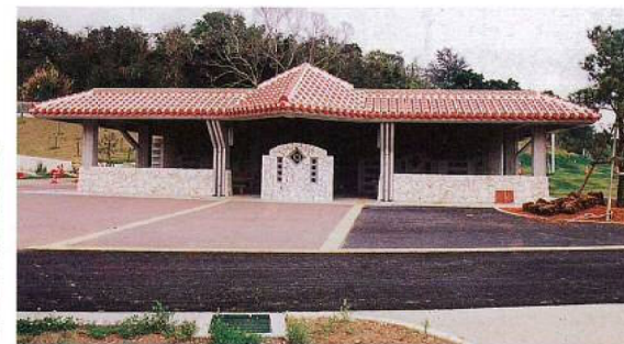
名称：総合運動公園かりゆし センター新築工事 所在地：沖縄市 工期：H10.8.28～H11.3.10 構造：RC造（地上1階建） 延面積：704㎡ 総工事費：64,086千円
