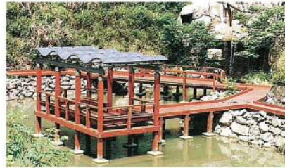
工期：H9.1.15～ H9.3.30 構造：木造 地上1階 延面積：— 総工事費：41,365千円
