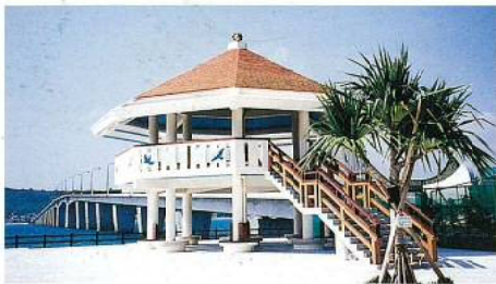
名称：浜比嘉大橋橋梁整備第5期工事 （展望台及び便所建築工事）
