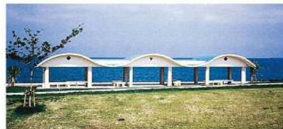
所在地：与那城町 工期：H8.8.31～H8.12.28 構造：RC造 地上1階 延面積：60㎡ 総工事費：13,390千円
