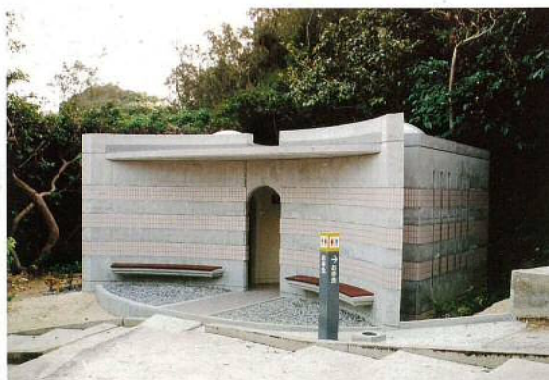
名称：健児之塔便所新築工事 所在地：糸満市 工期：H7.12.29～H8.3.25 構造：RC造地上1階 延面積：23㎡ 総工事費：22,248千円
