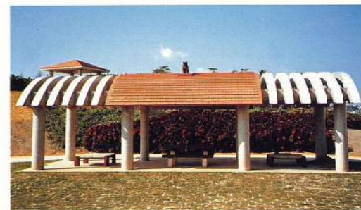
名称：中城湾港(新港地区)緑地(Ⅱ) 休憩所新築工事 所在地／沖縄市 工期／H6.12.28～H7.3.25 構造／RC造(地上1階建) 延面積／68m 2 総工事費／18,128千円
