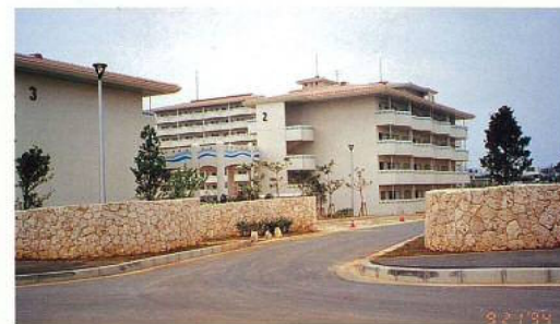
名称：県営久貝団地建設工事 所在地／平良市 工期／H5.7.1～H6.10.3 構造／RC造(地上8階建) 延面積／8,672m 2 総工事費／1,917,751千円
