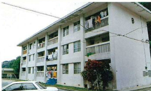
名称: 北部職員住宅改修工事 所在地/名護市 工期/H6.10.11~H6.12.9 構造/RC造(地上3階建) 延面積/— 総工事費/10,197千円
