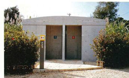
名称: 白梅の塔便所新築工事 所在地/糸満市 工期/H7.1.6~H7.3.25 構造/RC造(地上1階建) 延面積/21m 2 総工事費/10,899千円
