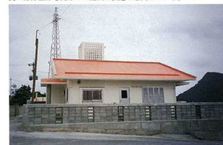
敷地全体が防風林のフクギで囲まれ極力、樹木を切らないよう設計に配慮した。屋根を片流れのモダンなデザインとし平面配置の北側の部分全体を高床にし通風と快適さを出している。
