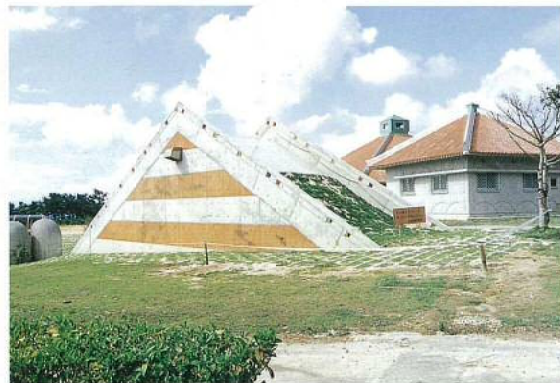
▲電気室側外観
