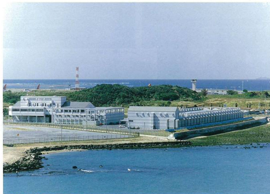
▲ 北東側からの景観・東シナ海に面している
