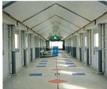
▲ ゲート棟 2階内部
