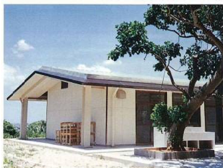
▲沖縄県立芸術大学(金工・木工棟)
