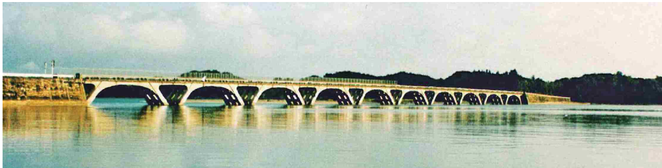
2代目屋我地大橋（昭和38年～平成4年）塩害、老朽化による架け替え
