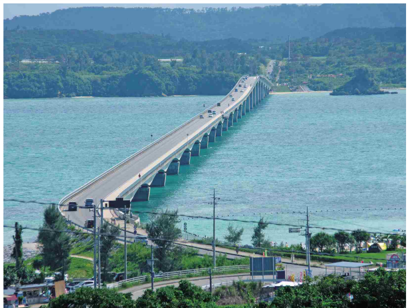
古宇利大橋全景 (古宇利島から屋我地島向け)
