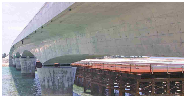
上部工変断面箱桁
