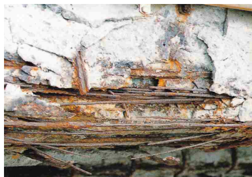
旧野甫大橋の塩害状況（平成11年11月撮影）
