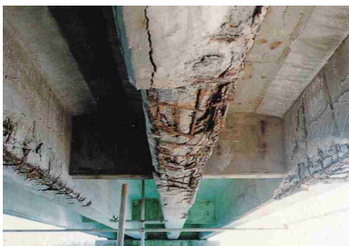
旧野甫大橋の塩害状況（平成11年11月撮影）
