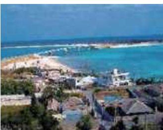
のほ 野甫大橋 ⑱
