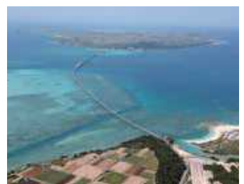
いらぶ 伊良部大橋 ㉑
