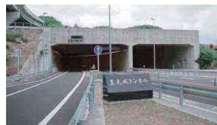
豊見城トンネル
