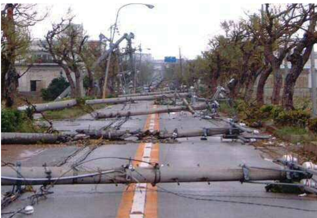
平良城辺線(宮古島市城辺) 平成 15 年台風 14 号で倒壊した電柱
