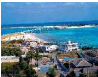
のほ 野甫大橋 ⑱
