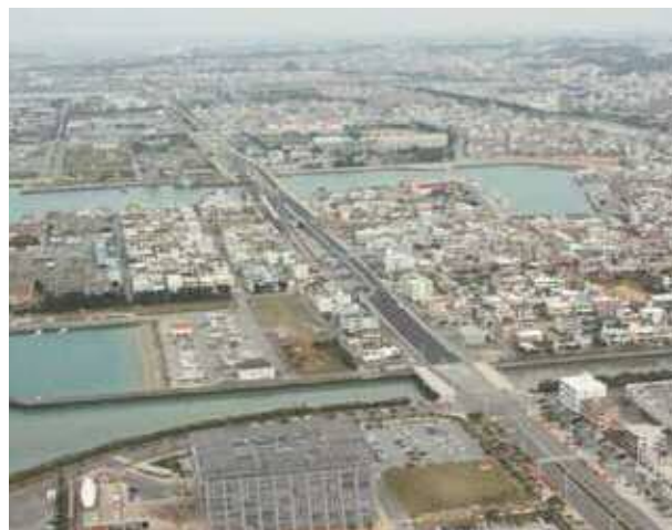
国道331号 糸満道路
