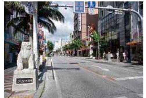
○街路整備事業（国際通り）
