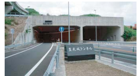
豊見城トンネル
