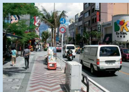
電線共同溝整備事業(国際通り)
