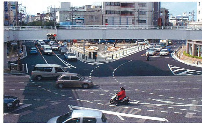
交通安全施設等整備事業（交差点改良：県道47号線 那覇市東町）
