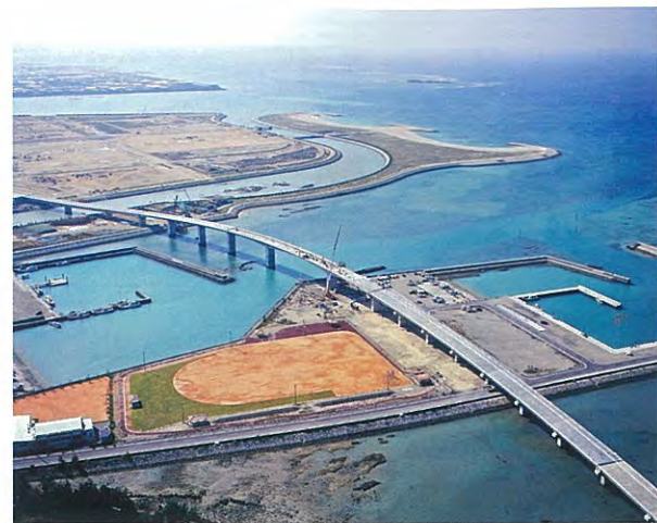
国道331号豊見城道路
