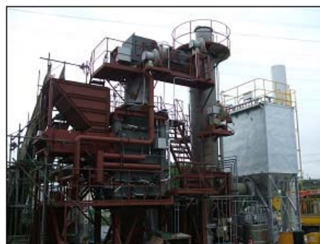
完成した中型焼却炉
