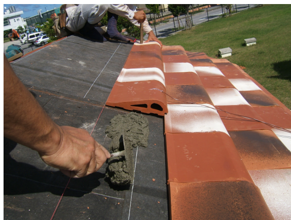
新しい瓦の施工
