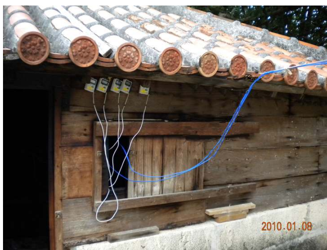
現場でのモニタリング
