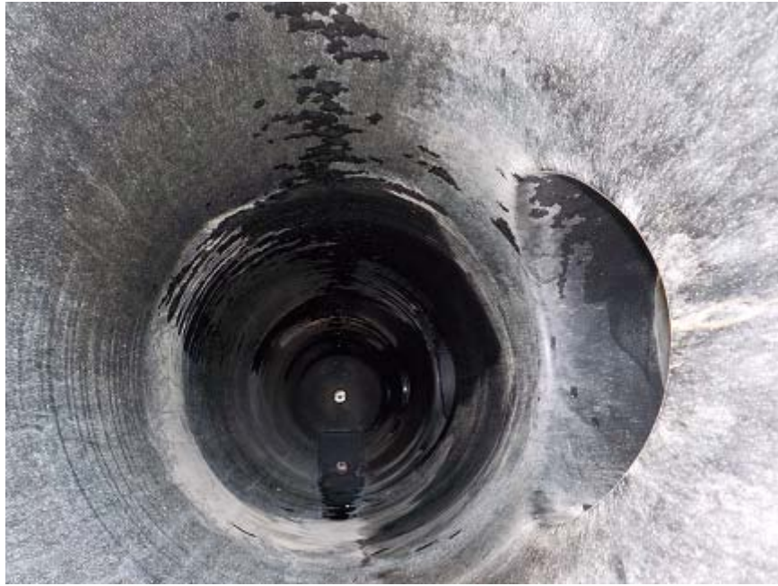
図 2-17 ユニット B 凝縮器 海水ヘッダ配管内
