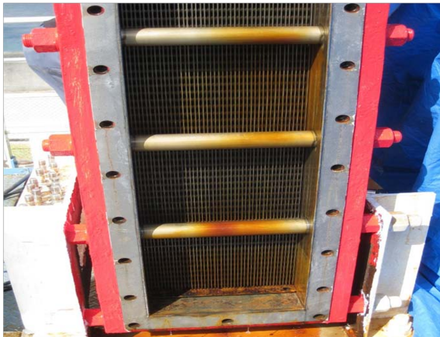
図 2-10 ユニット A 蒸発器 洗浄作業後の状況
