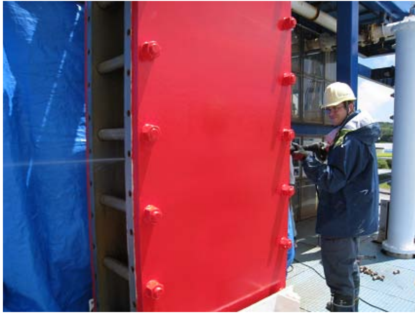
図 2-9 ユニット A 蒸発器ジェット洗浄作業
