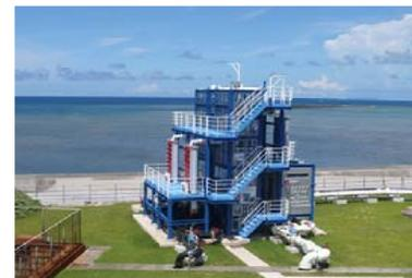
**実証** 現時点で世界唯一の実証運転設備として連続発電中。出力100kWクラス。
