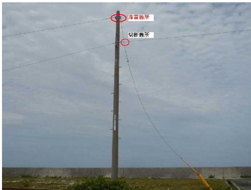
図 2-17 【写真】平成 26 年 5 月 落雷事故
