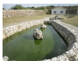
集落排水施設
