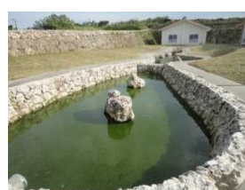
集落排水施設
