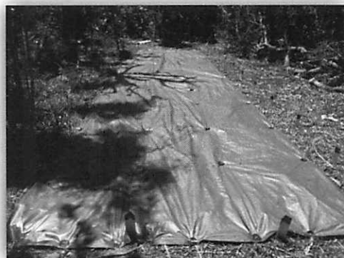
写真-2 防草シートの施工状況
